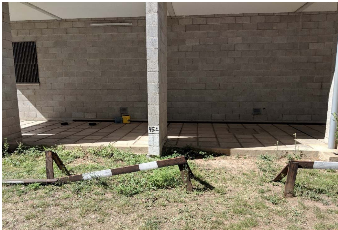
Imagen 4 - Señalización Estacionamiento HEGyPA
