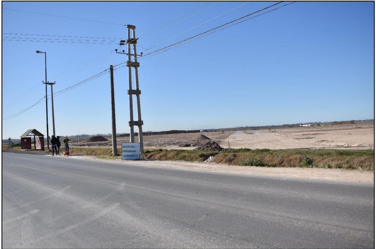
Imagen N° 4 - Ejecución de calzadas internas del nuevo barrio. Fuente: Propia.
