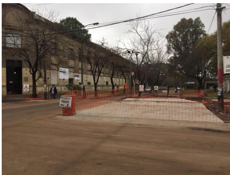
Ilustración 7 - Ingreso visto desde el exterior.
