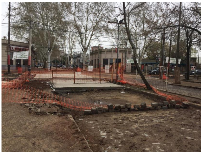
Ilustración 6 - Ingreso visto desde el interior.
